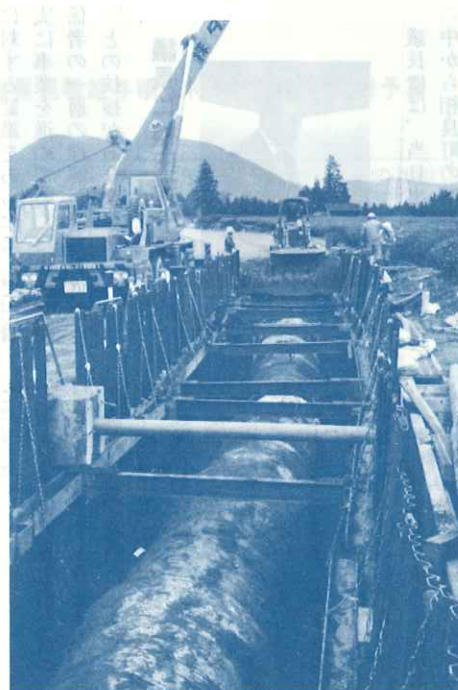
▲中央幹線水路埋管工事現場
