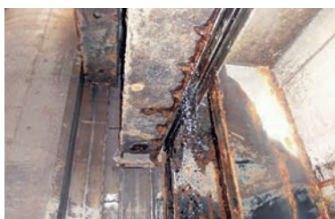
予備取水工改修
