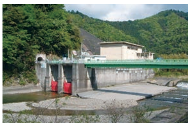
制水ゲート改修ほか
