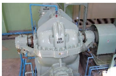
3号ポンプ改修
