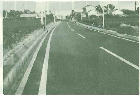
▲第1期工事を終った3号幹線農道 (島田市谷口原地内)
