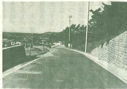
▲着々と工事が進む20号幹線農道 (御前崎町白羽地内)
