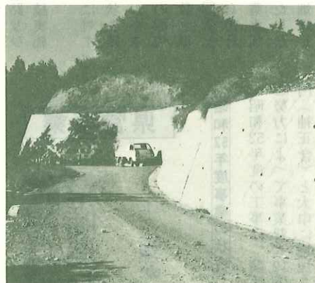
▲第759号支線農道工事現場 (榛原町桃原地内)
