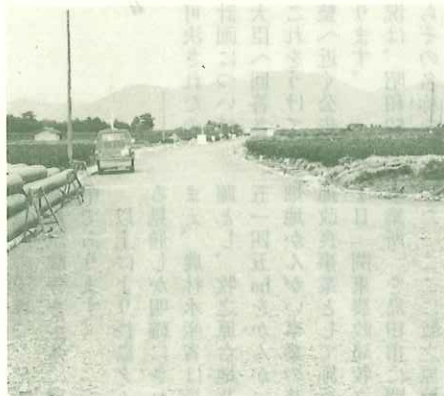
▲第1号幹線工事現場
