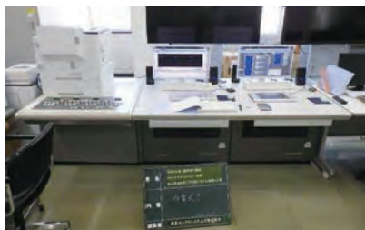
水管理制御システム更新工事
