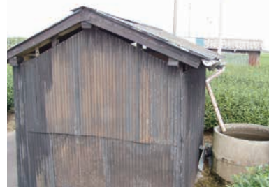
雨水をためていた施設
