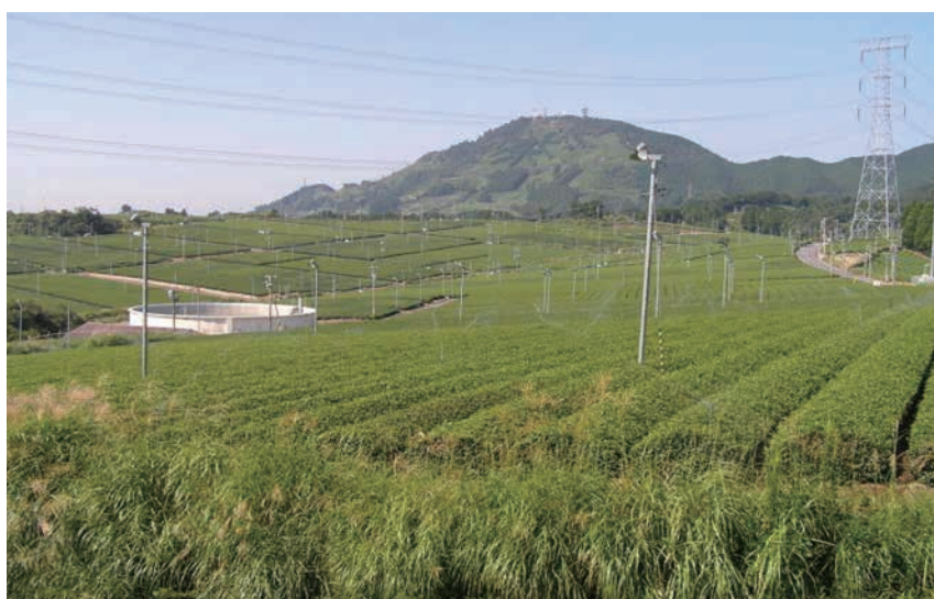
国営調整水槽から撮影
