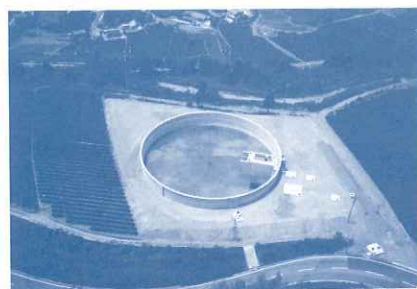
完成した第2号調整水槽 (菊川町沢水加)
