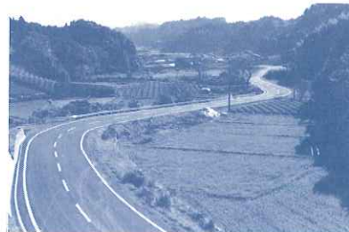
完成した8号幹線農道 (台地を横断し、菊川町から相良町を結ぶ)
