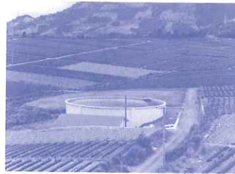
金谷町安田原(8工区) 満水のファームポンド(V=6,000m³)
