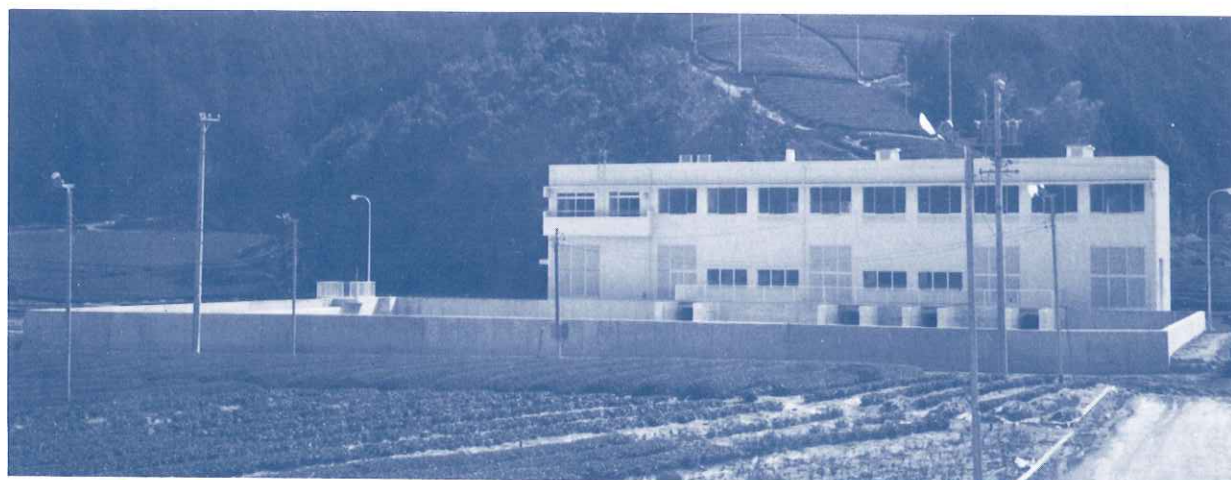
▲完成間近な揚水機場 <1階と地下……ポンプ室 2階……中央管理所>
