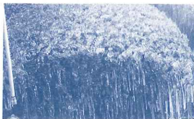
スプリンクラーにより散水氷結した状況
