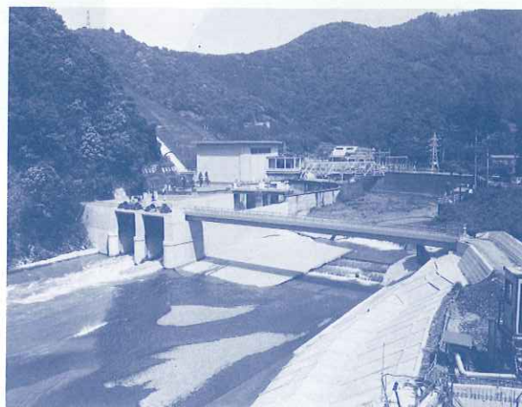
▲完成した取水工
