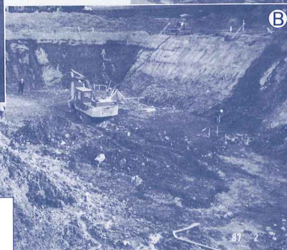
▶幹線水路工事(金谷町菊川) 県営畑総西部一号幹線道路へのパイプライン埋設状況
