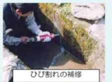
ひび割れの補修
