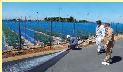
設置した給水栓の圧力調査
