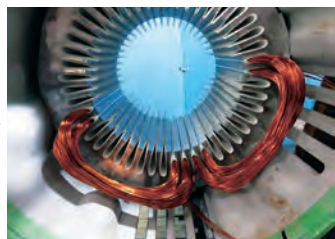
電動機コイル巻直し中
