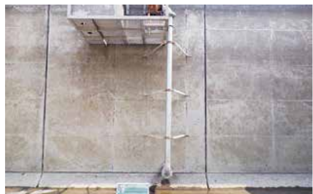
流入管修繕 施工後
