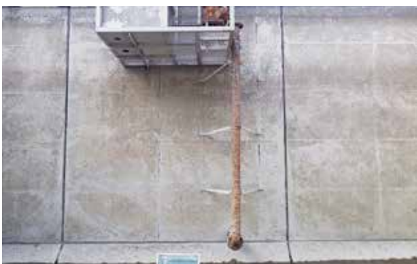
流入管修繕 施工前
