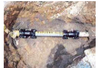
パイプラインの修理
