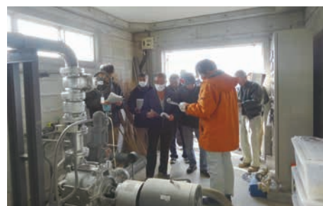
ポンプ設備点検方法について
