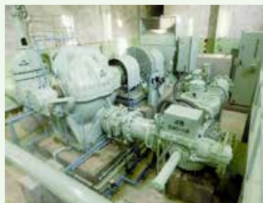
電動機他整備
