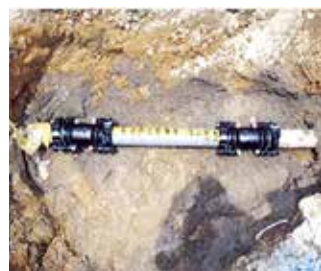
パイプラインの修理
