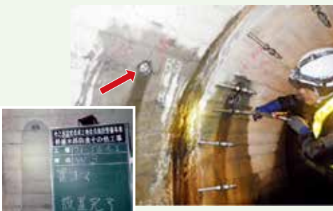
トンネル目地部の止水
