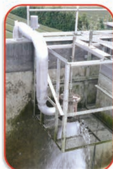
施工後(流入管付替)
