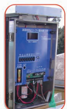
施工後(凍霜害防止コントローラ)
