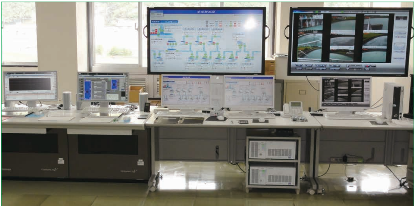
更新された新LCDシステム方式 中央監視操作設備
