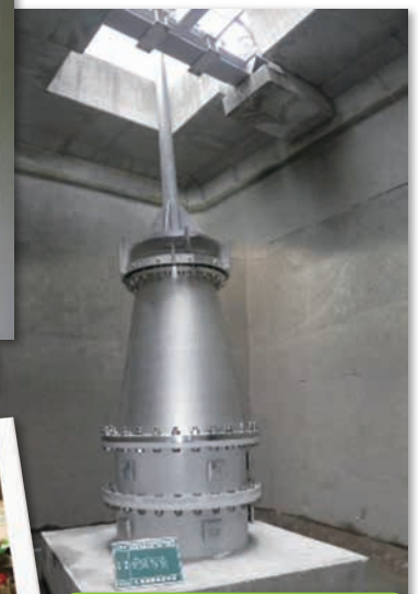
ディスクバルブの改修 (H25年度の施工事例)
