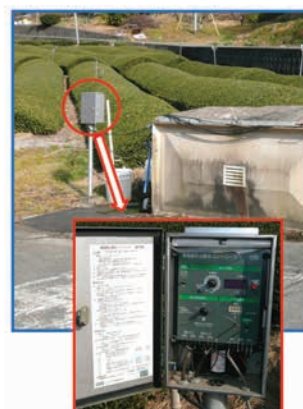
施工前(凍霜害防止コントローラ)
