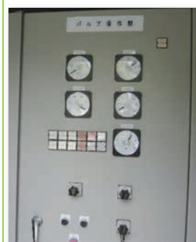
バルブ操作盤の改修
