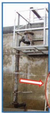
施工前(流入管腐食)
