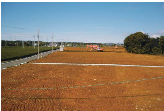
▲ 鬼女新田地区の区画整理工事 (平成21年11月の状況)
