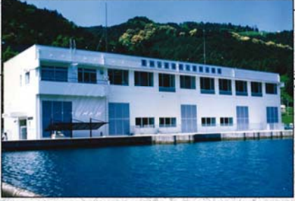
国営揚水機場
