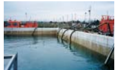
火災消火の時、ファームポンドから吸水した消防車（実例写真）
